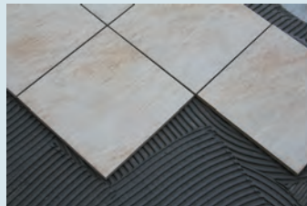
Seramiğin yerleştirilmesi
