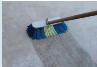
Yüzeyin temizlenip nemlendirilmesi
