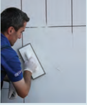
Dolgu malzemesinin duvara uygulanması
