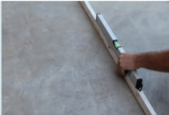
Yüzeyin düzgünlüğünün kontrol edilmesi
