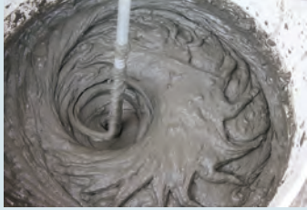
Karıştırıcı ile karıştırma
