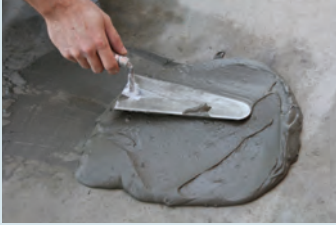
Harç mala yardımı ile yüzeye aktarılması
