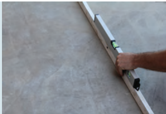
Yüzeyin düzgünlüğünün kontrol edilmesi
