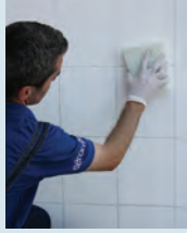
Nemli sünger ile derz yüzeyinin düzeltilmesi
