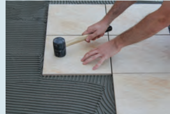
Çekiçle vurulup seviyelendirilmesi
