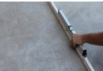
Yüzeyin düzgünlüğünün kontrol edilmesi
