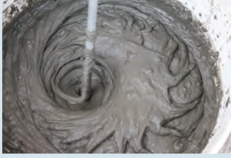
Karıştırıcı ile karıştırma
