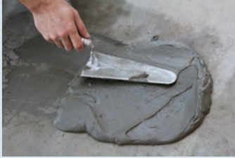
Harç mala yardımı ile yüzeye aktarılması
