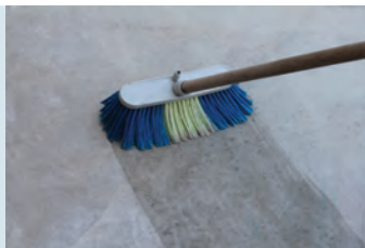
Yüzeyin temizlenip nemlendirilmesi
