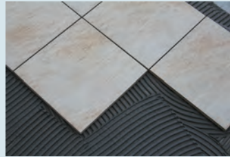
Seramiğin yerleştirilmesi
