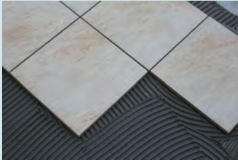
Seramiğin yerleştirilmesi
