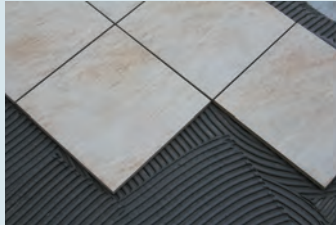
Seramiğin yerleştirilmesi
