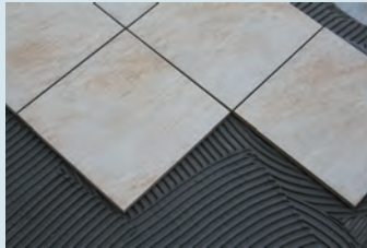
Seramiğin yerleştirilmesi
