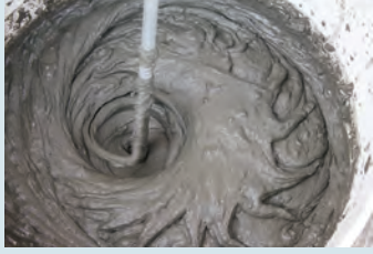
Karıştırıcı ile karıştırma
