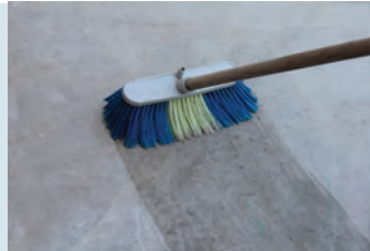
Yüzeyin temizlenip nemlendirilmesi
