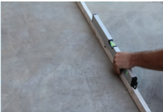
Yüzeyin düzgünlüğünün kontrol edilmesi
