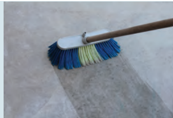
Yüzeyin temizlenip nemlendirilmesi
