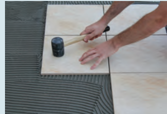
Çekiçle vurulup seviyelendirilmesi
