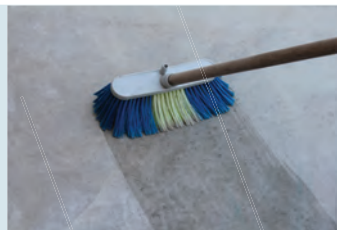
Yüzeyin temizlenip nemlendirilmesi
