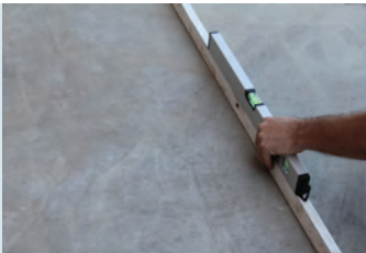
Yüzeyin düzgünlüğünün kontrol edilmesi
