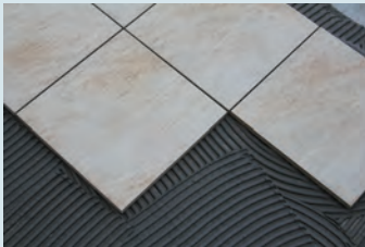
Seramiğin yerleştirilmesi
