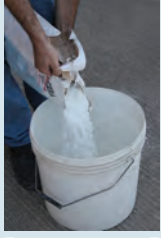
Harcın suya eklenmesi
