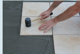
Çekiçle vurulup seviyelendirilmesi
