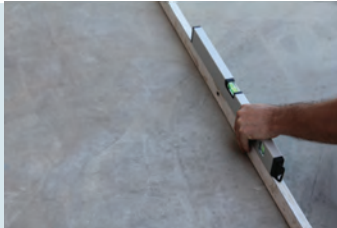
Yüzeyin düzgünlüğünün kontrol edilmesi
