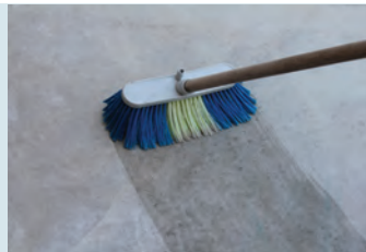
Yüzeyin temizlenip kuru olması
