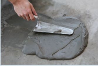
Harç mala yardımı ile yüzeye aktarılması
