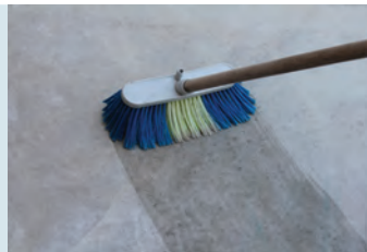
Yüzeyin temizlenip nemlendirilmesi
