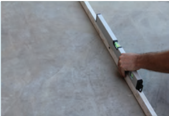
Yüzeyin düzgünlüğünün kontrol edilmesi
