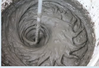
Karıştırıcı ile karıştırma
