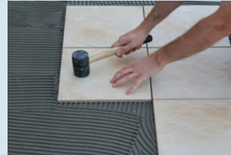
Çekiçle vurulup seviyelendirilmesi
