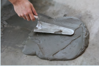
Harç mala yardımı ile yüzeye aktarılması
