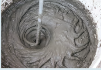
Karıştırıcı ile karıştırma
