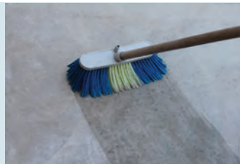
Yüzeyin temizlenip nemlendirilmesi
