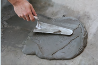
Harç mala yardımı ile yüzeye aktarılması
