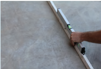
Yüzeyin düzgünlüğünün kontrol edilmesi
