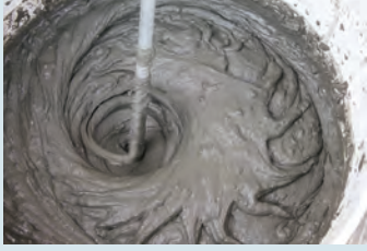
Karıştırıcı ile karıştırma
