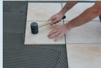
Çekiçle vurulup seviyelendirilmesi
