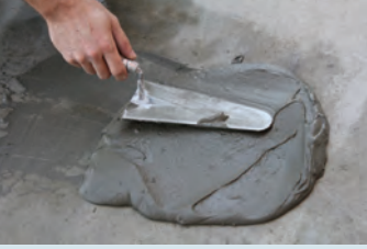
Harç mala yardımı ile yüzeye aktarılması
