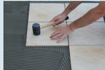
Çekiçle vurulup seviyelendirilmesi
