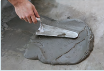
Harç mala yardımı ile yüzeye aktarılması
