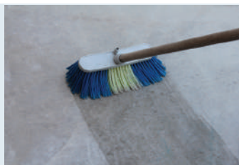
Yüzeyin temizlenip nemlendirilmesi
