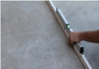
Yüzeyin düzgünlüğünün kontrol edilmesi
