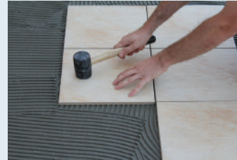
Çekiçle vurulup seviyelendirilmesi
