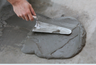
Harçın mala yardımı ile yüzeye aktarılması
