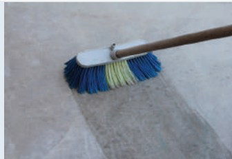
Yüzeyin temizlenip nemlendirilmesi
