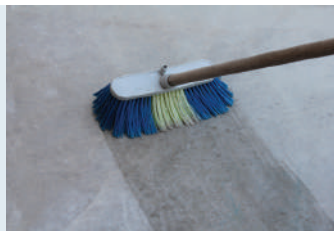
Yüzeyin temizlenip nemlendirilmesi
