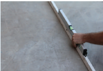
Yüzeyin düzgünlüğünün kontrol edilmesi
