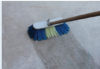
Yüzeyin temizlenip nemlendirilmesi
