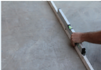
Yüzeyin düzgünlüğünün kontrol edilmesi
